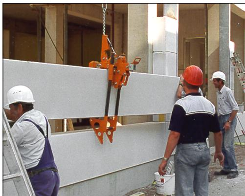
Le grappin plat FG/U avec un mécanisme de soutien inférieur pour le montage en toute sécurité de dalles murales, même hors de la proximité du sol.
